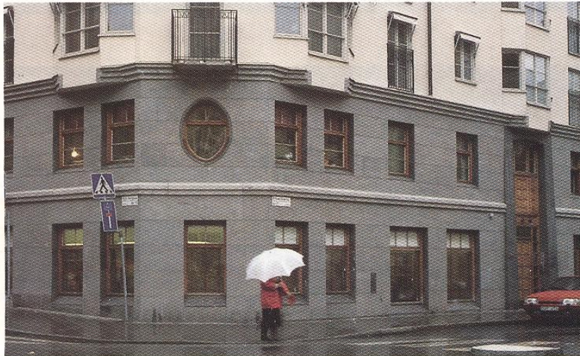
Husets två nedersta våningar är klädda med Bårarp-gnejs, avdelade med horisontell betonglist.
