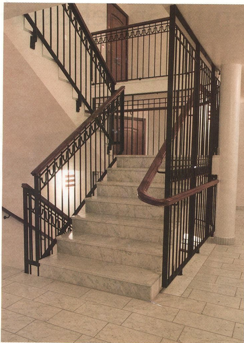
Trapphus med golv och steg av Carrara-marmor.
